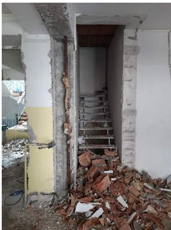
Foto: Rimozione Piattaforma montacarichi e rampa scala rinvenuti all'interno del vano non accessibile
