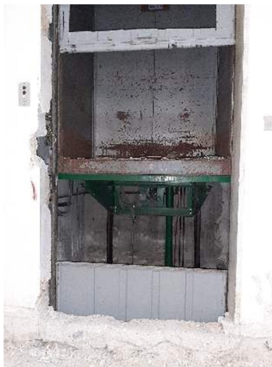
Foto: Rimozione Piattaforma montacarichi e rampa scala rinvenuti all'interno del vano non accessibile
