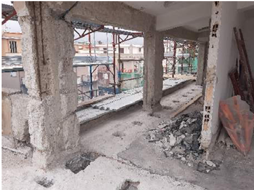
Foto: Lavori di "messa a nudo" strutture portanti in c.a.
