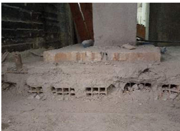
Foto: Solaio in latero cemento posto al di sotto della pavimentazione
