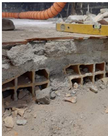
Foto: Solaio in latero cemento posto al di sotto della pavimentazione
