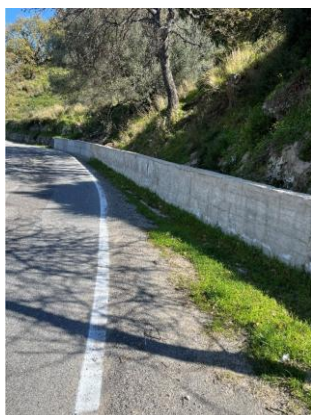
Foto 11 –Parapetto e cunetta di contenimento detriti
