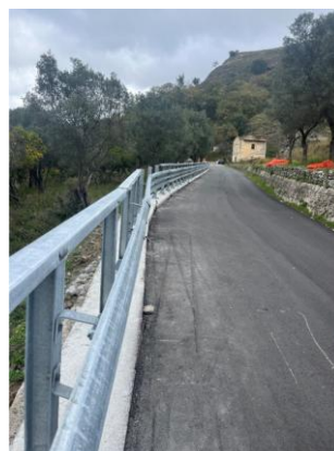
Foto 3 –sede stradale ripristinata e barriera di sicurezza
