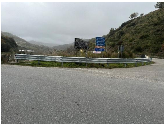
Foto 1–barriera H2 e segnaletica
