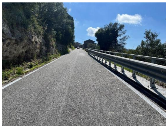
Foto 12 – Quinto tratto Barriera di sicurezza H2 e manto stradale - segnaletica orizzontale
