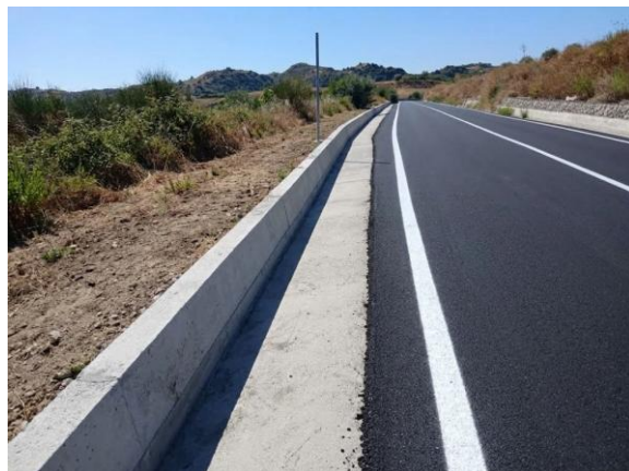
Foto 2 – Cordolo in calcestruzzo e cunetta a bordo strada, nuovo tappeto d'usura e segnaletica orizzontale
