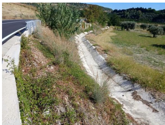
Foto 8 – Canaletta in embrici prefabbricati per il convogliamento delle acque al recettore
