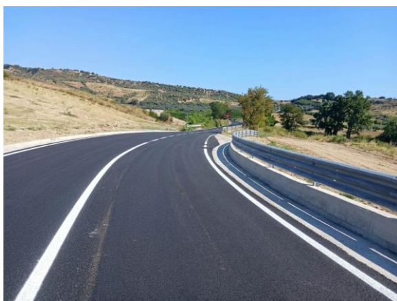
Foto 7 – Curva di accesso al ponte con nuova barriera di sicurezza e cordolo
