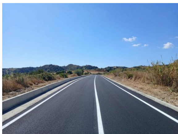
Foto 4 – Tratto stradale rifatto con cordoli laterali e nuova segnaletica orizzontale
