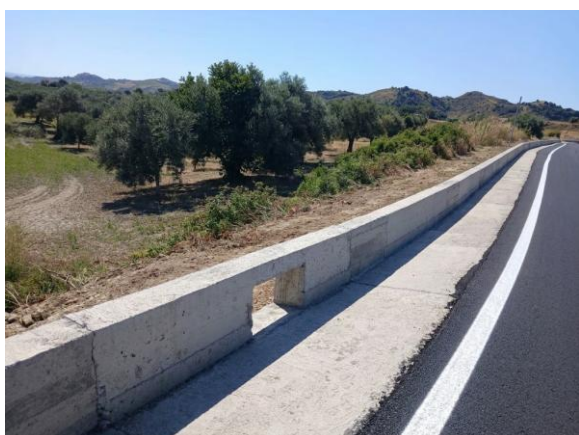
Foto 3 – Cordolo in calcestruzzo con apertura di scarico delle acque e cunetta
