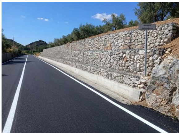
Foto 1 – Muro di contenimento in gabbioni metallici e pietrame con cunetta alla francese e nuova pavimentazione
