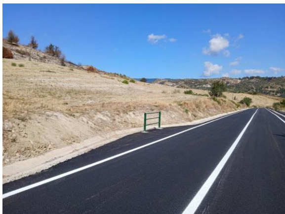
Foto 5 – Scarpata riprofilata, cunetta al piede e nuova pavimentazione
