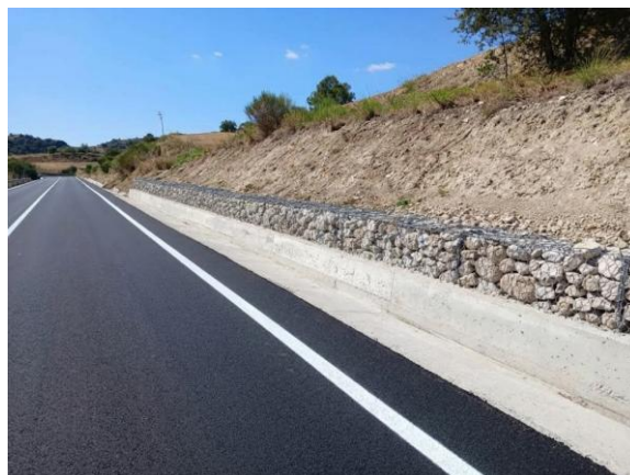
Foto 6 – Muro in gabbioni metallici e cunetta alla francese al piede della scarpata
