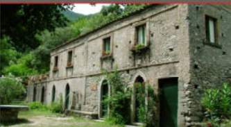
2. Terme Bagni di Guida (Bivongi): i caseggiati dello stabilimento termale per l'utilizzo a scopi terapeutici, di acque alcaline-solforee, permangono ancora il toponimo Acque Sante.
